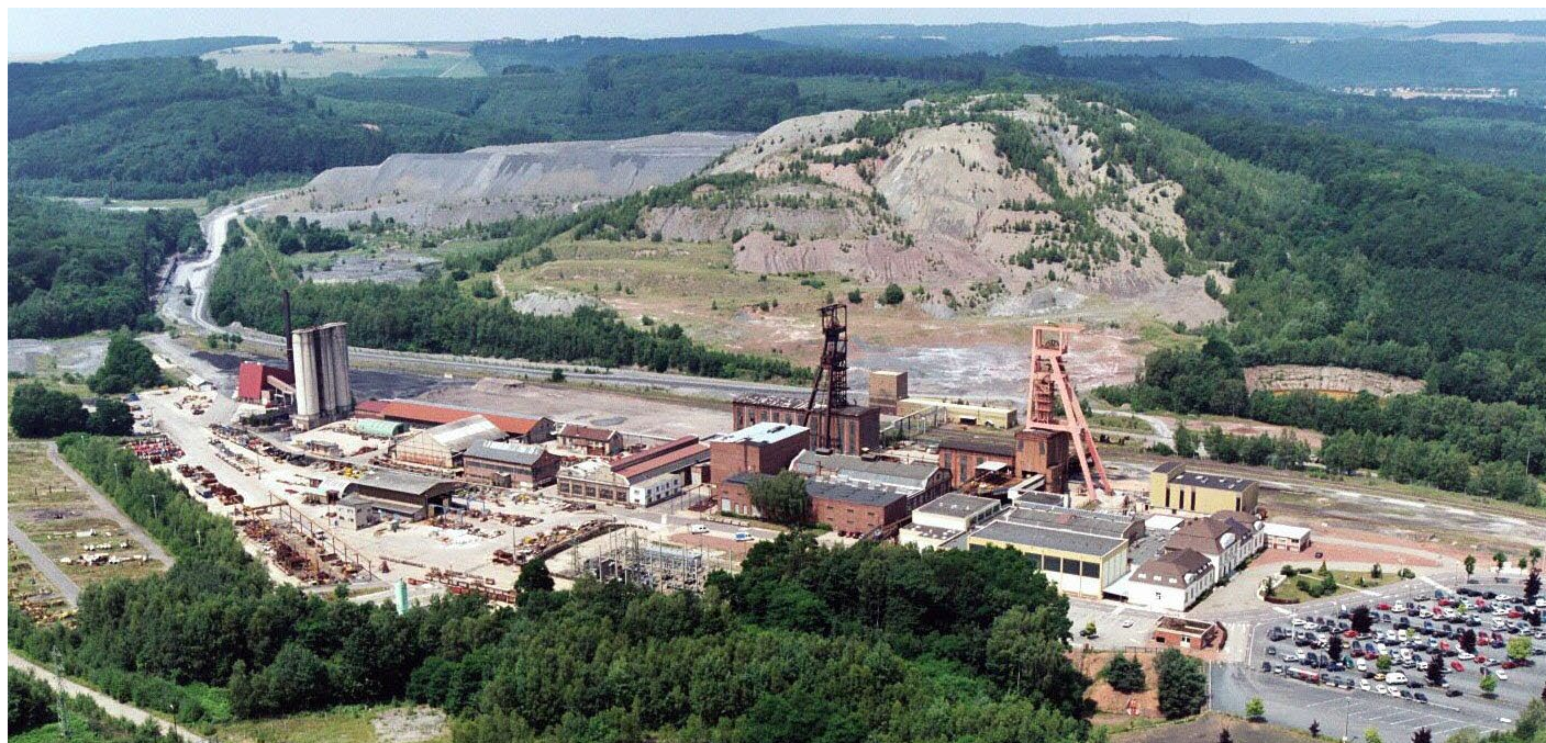
Vue du siège 2 de La Houve, avec ses chevalements, à Creutzwald. Photo Fonds HBL
